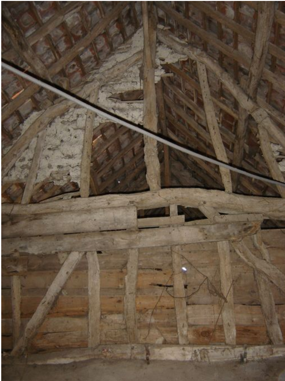
Détail de la charpente des bâtiments annexes.
