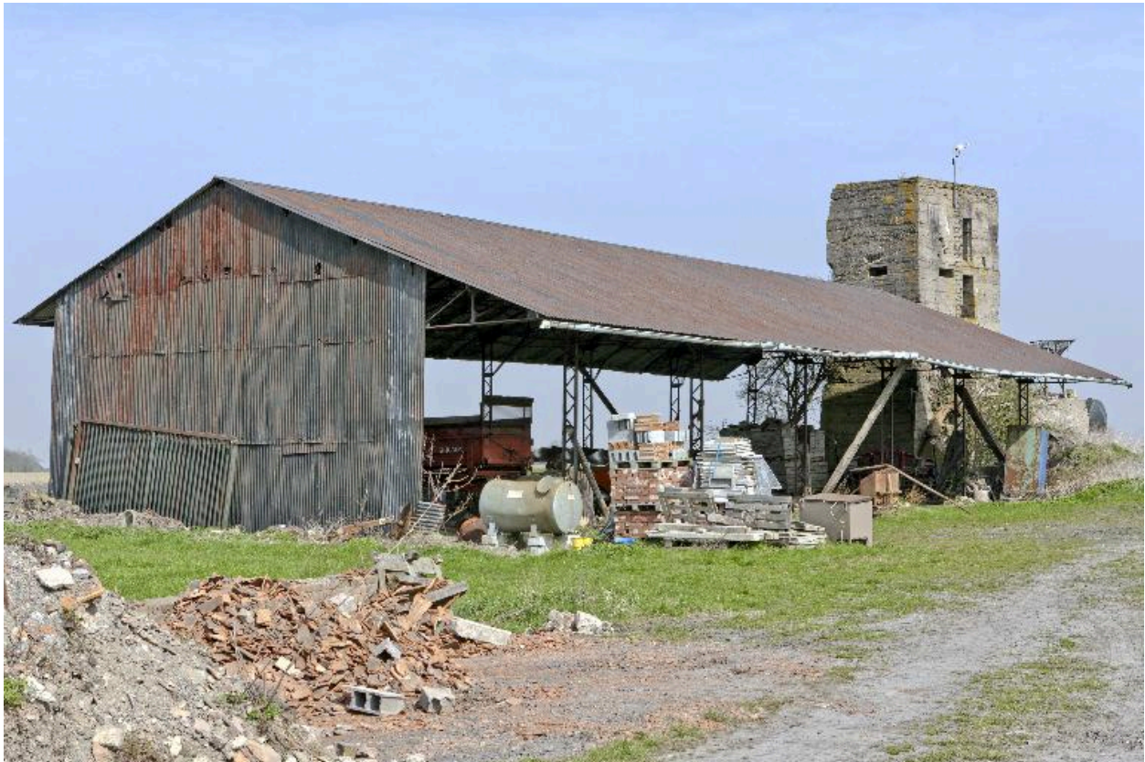
Vue générale vers le nord-est
