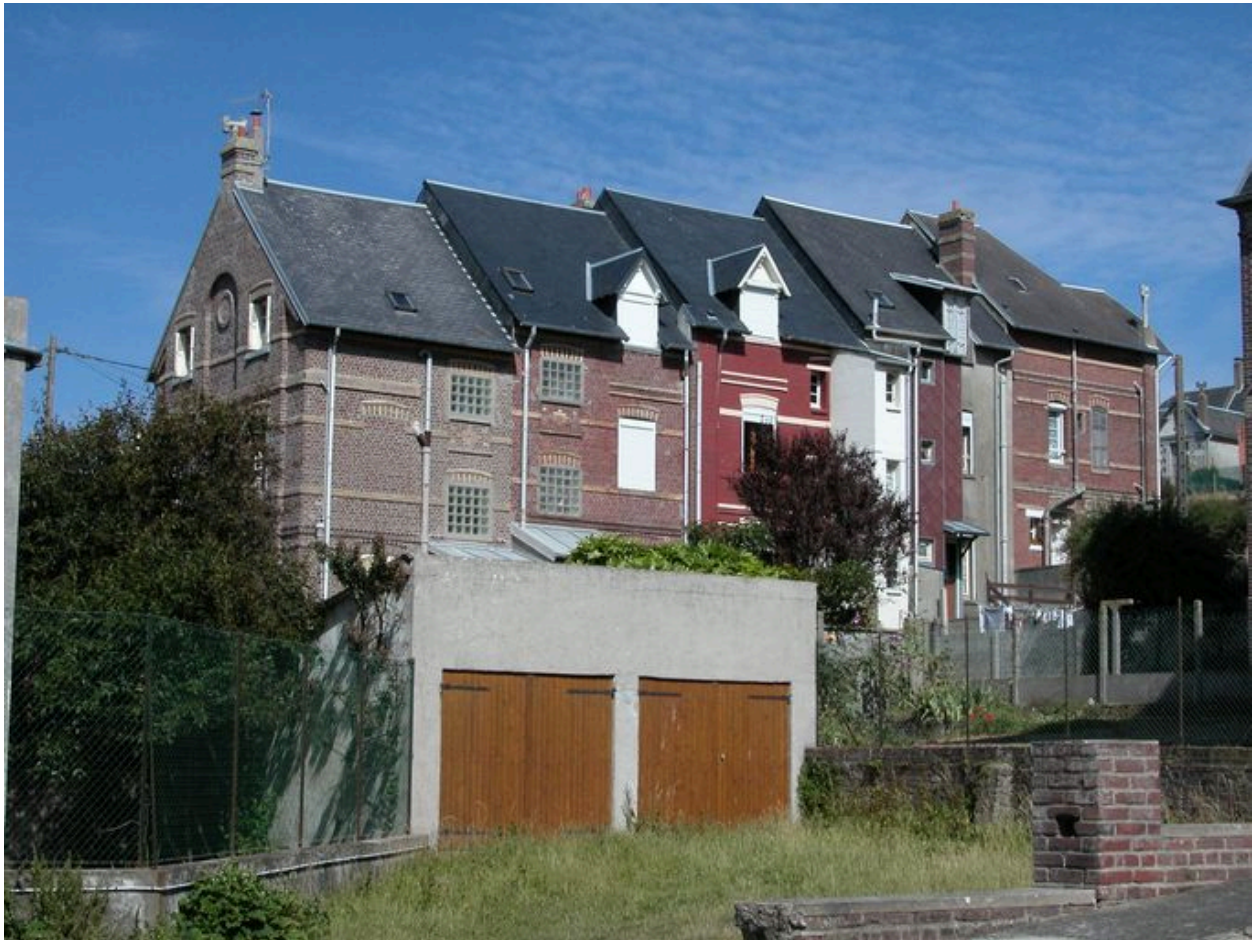
Les maisons de la rue de la Brise, élévations postérieures vues depuis la rue de la Mer.
