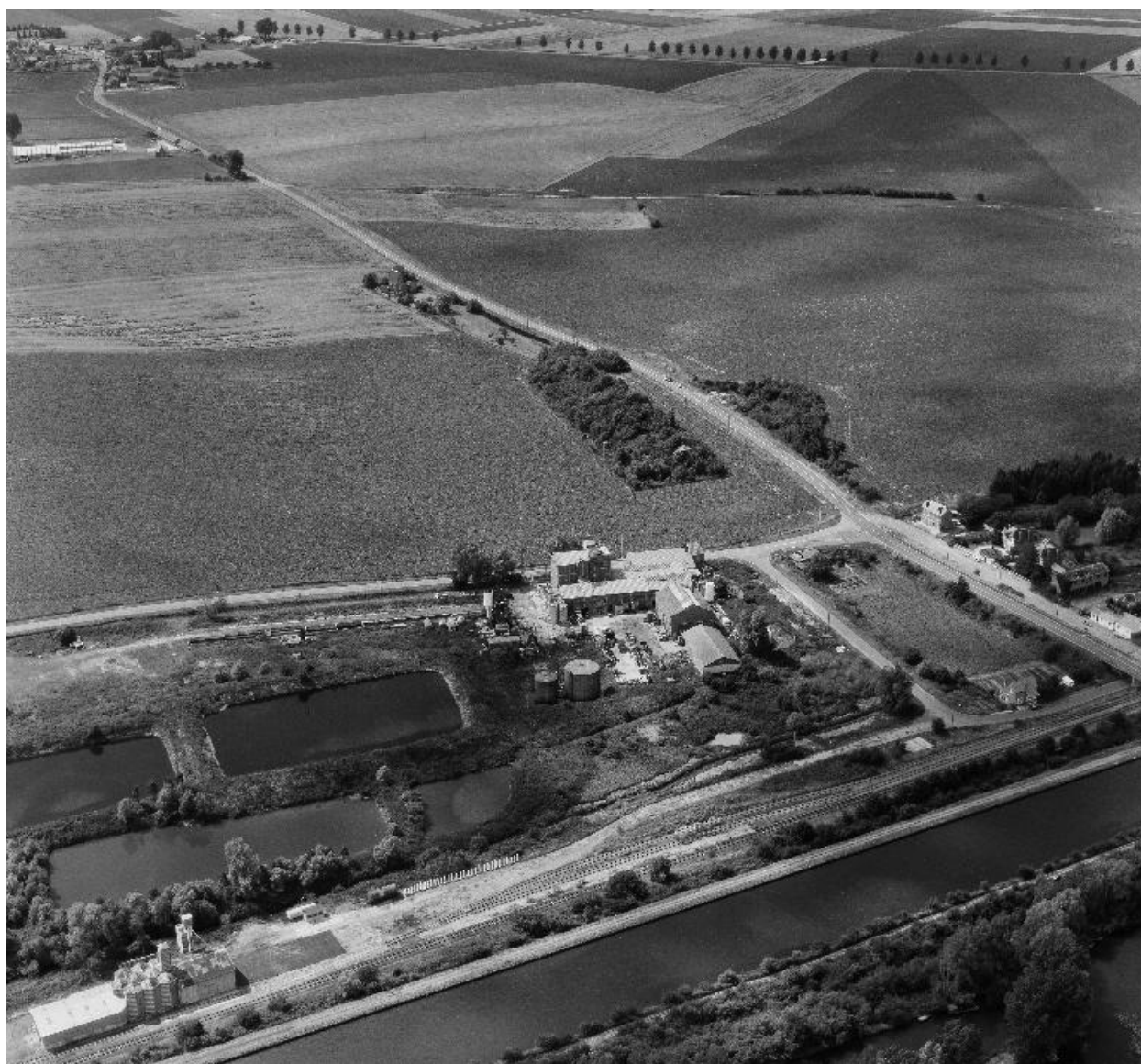
Vue aérienne, flanc est.
