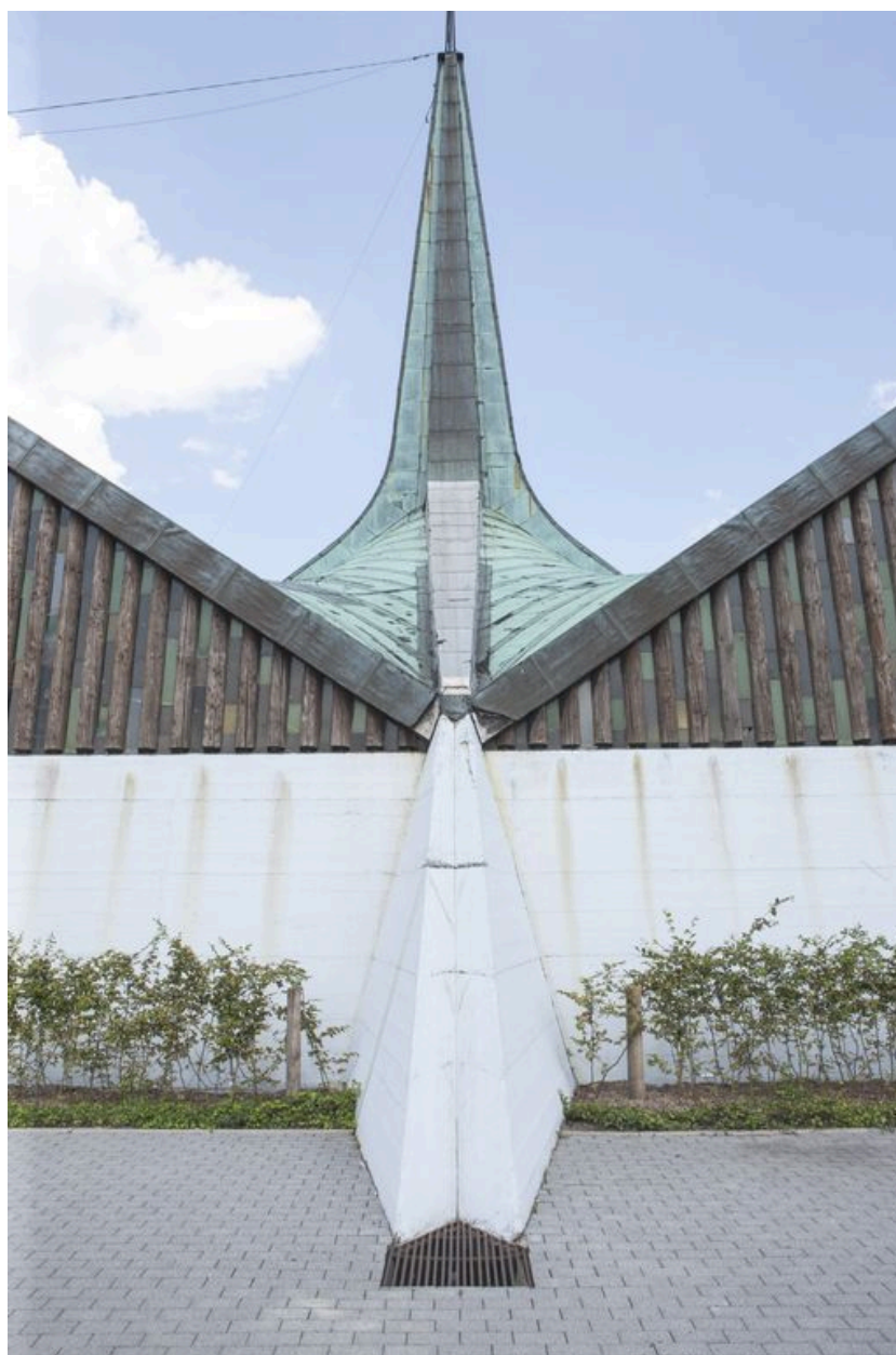
Vue axiale et rapprochée de l'élévation sud.
