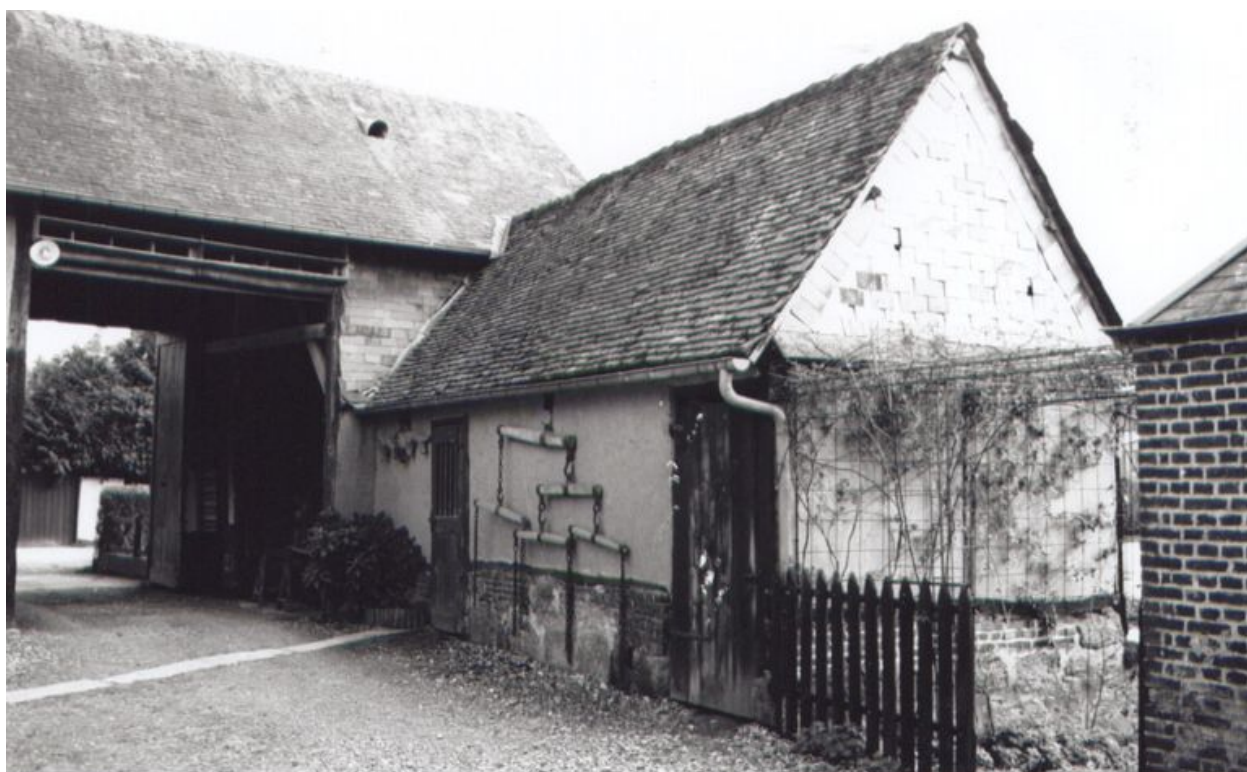
L'entrée charretière sous porche, façade sur cour.
