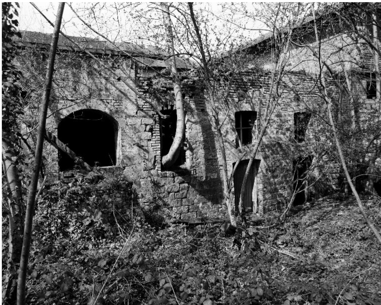
Atelier de fabrication, flanc est.
