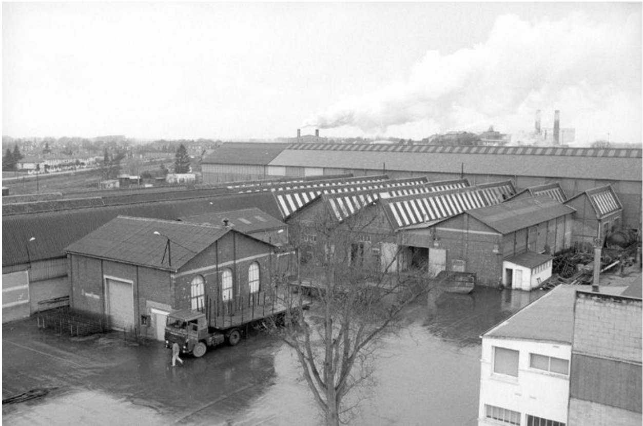
Atelier de fabrication : vue générale.
