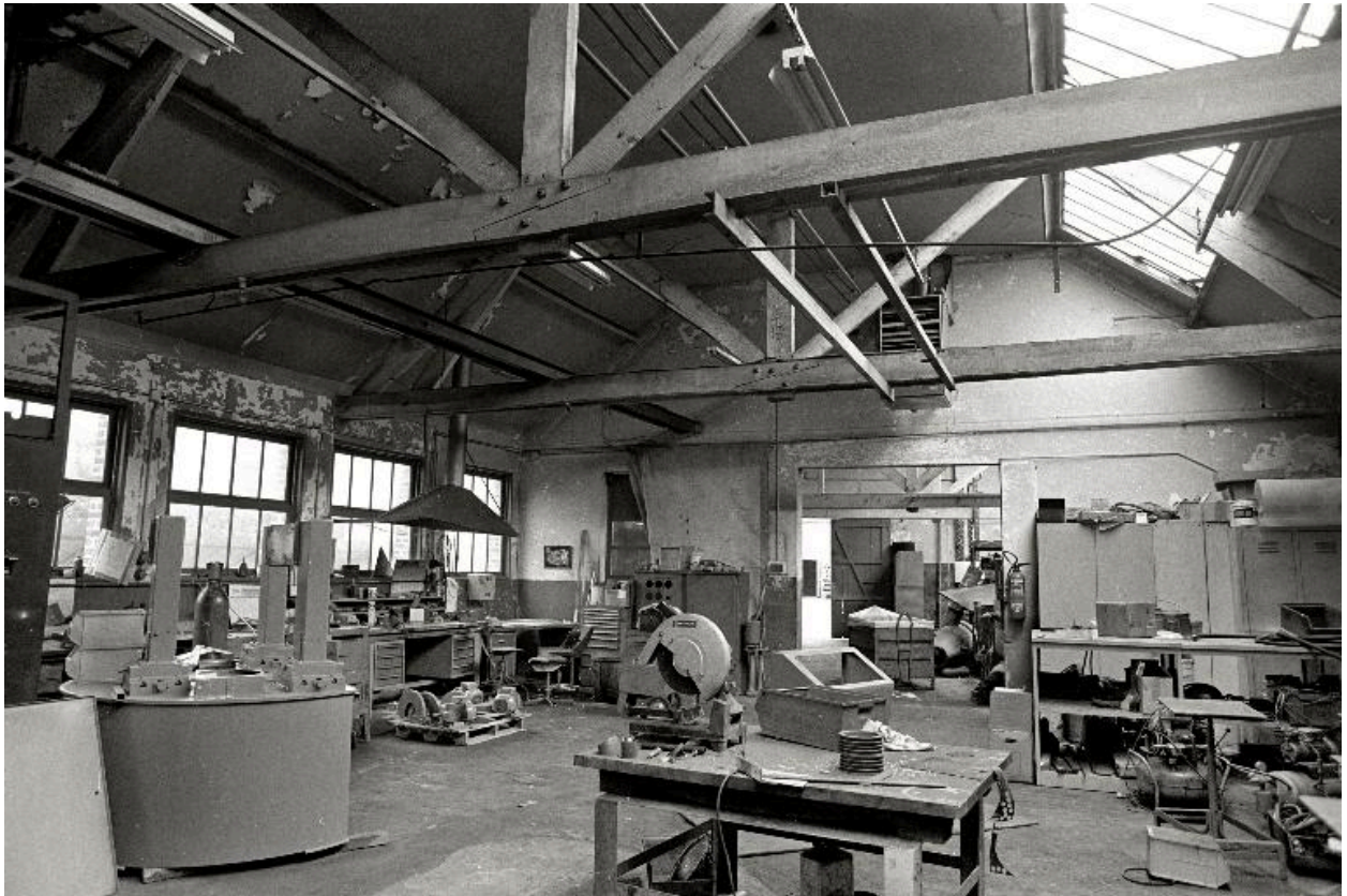
Atelier de fabrication (1946), vue intérieure en 1990.
