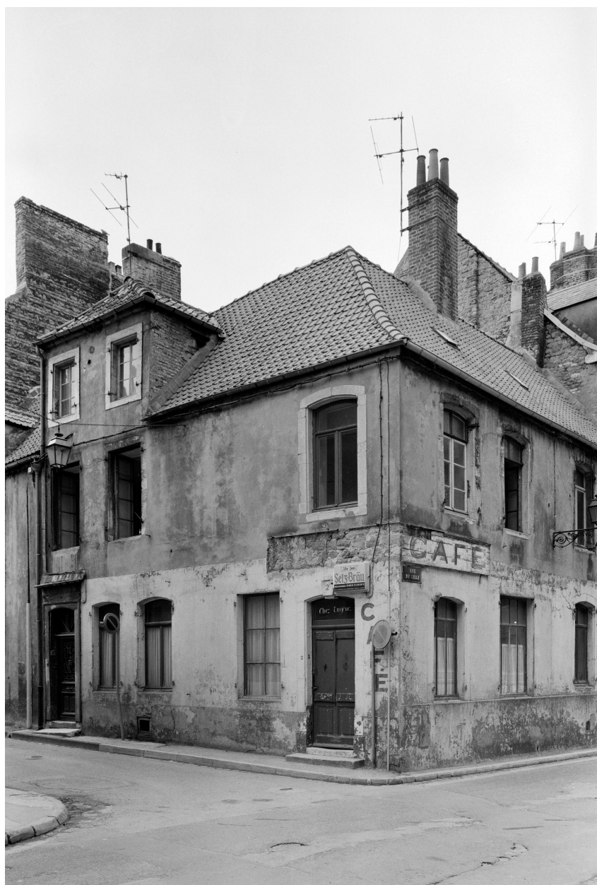
Vue générale avant restauration.
