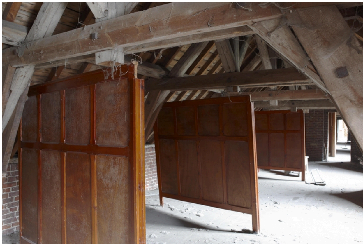
Les combles de l'aile sur rue.
