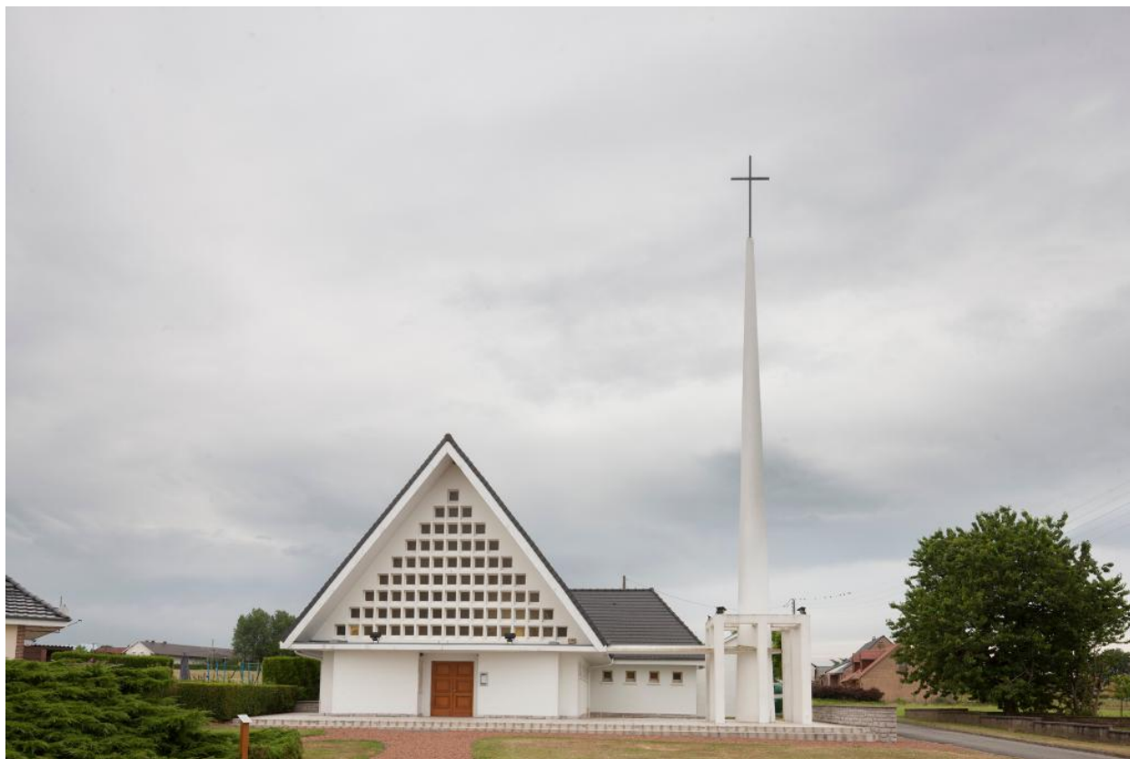
Vue générale vers le nord-est.
