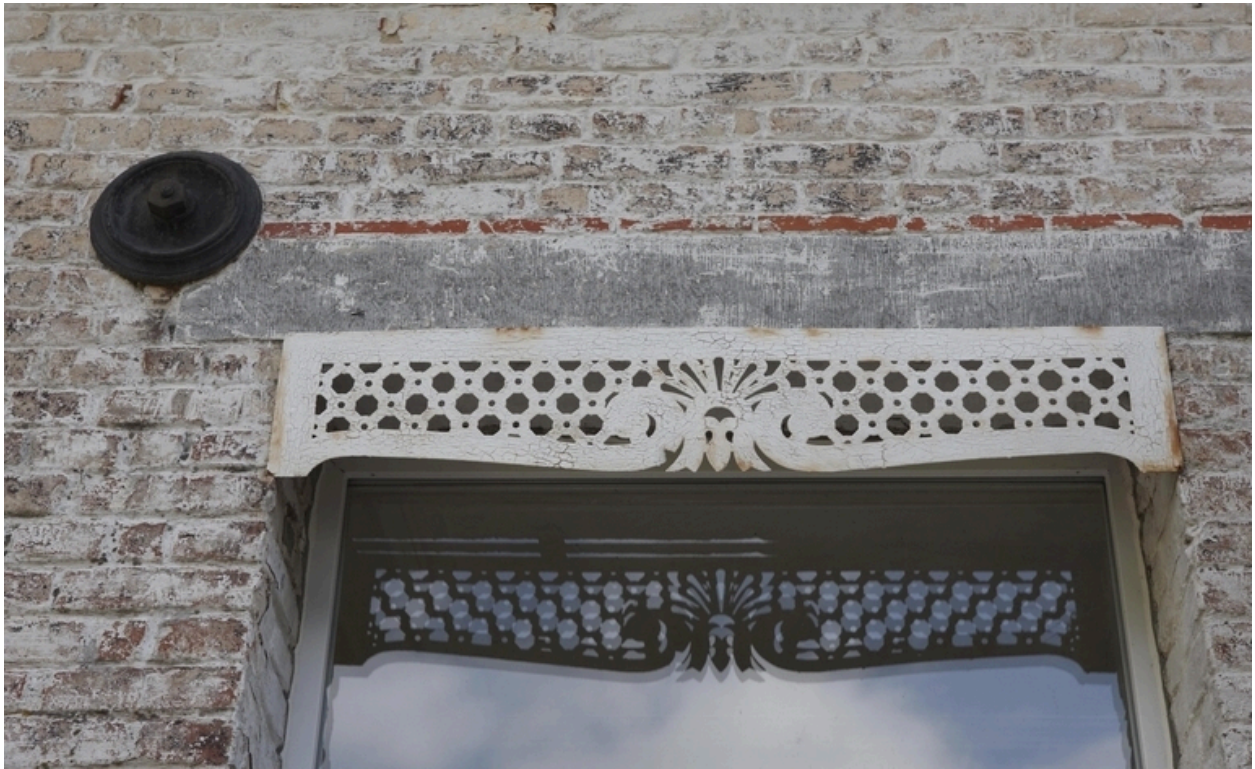
Détail du lambrequin de store d'une fenêtre.
