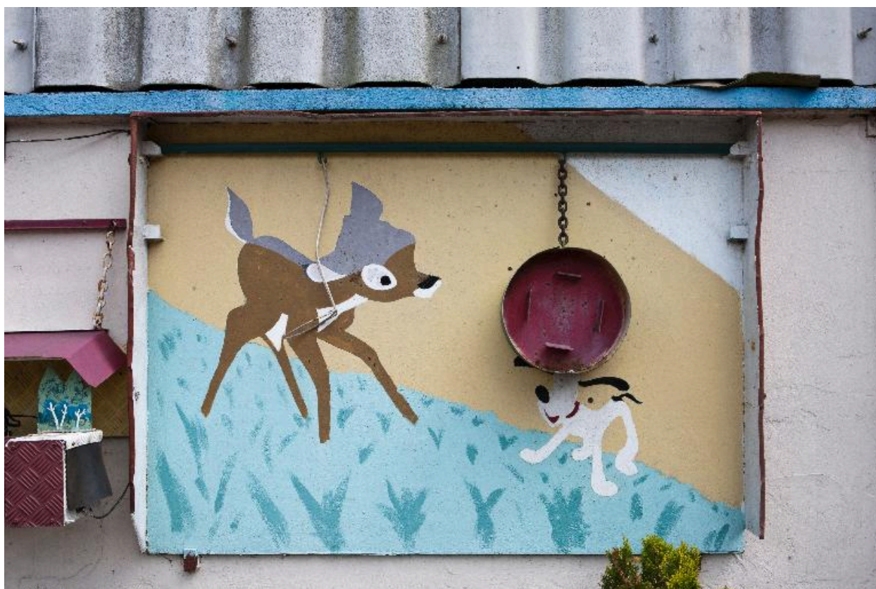
Mur de la cour, détail.
