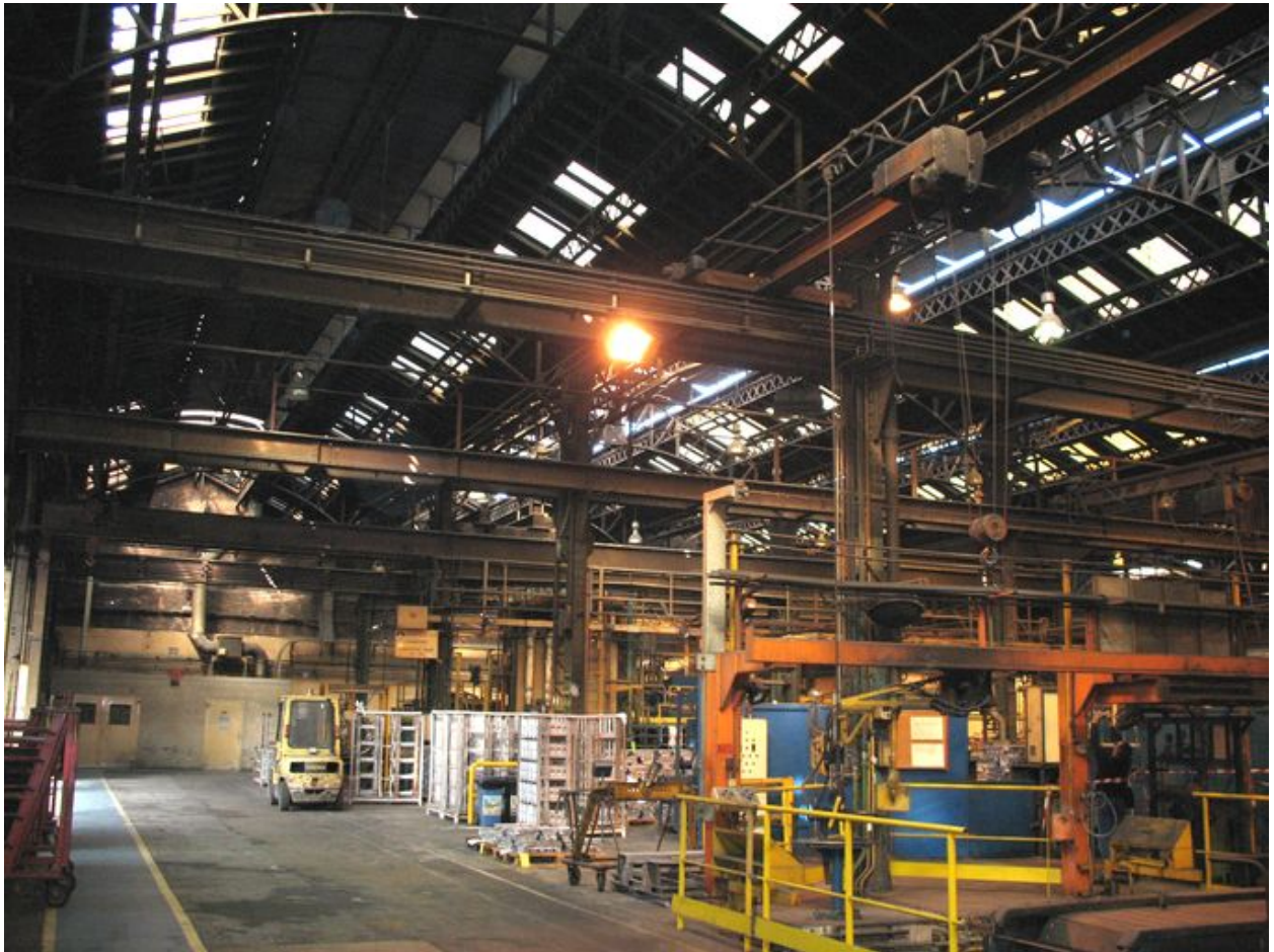
Intérieur des halles Eiffel.
