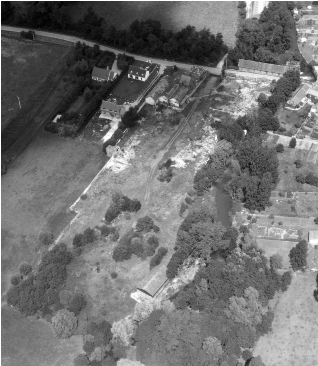
Vue aérienne, flanc sud.
