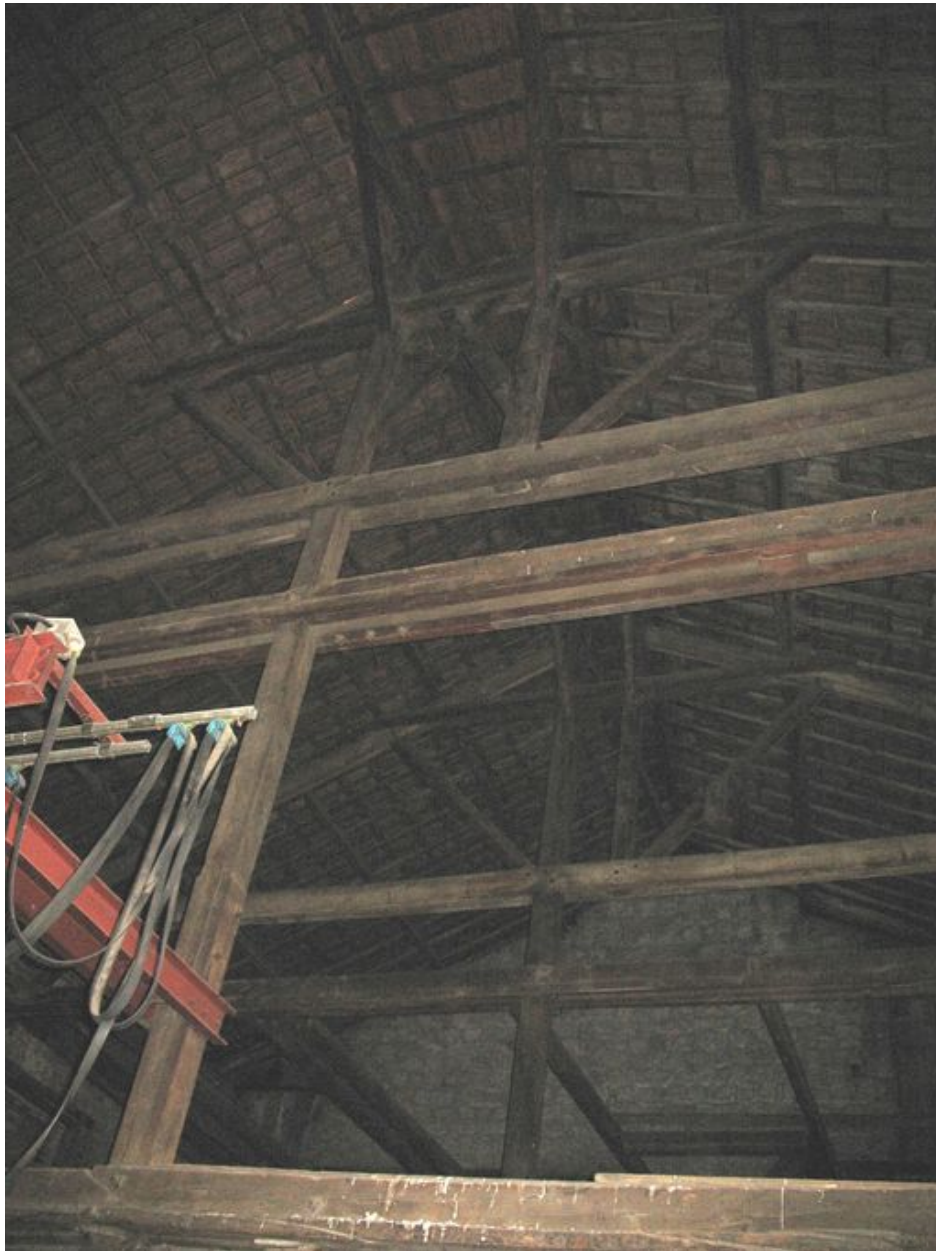
Charpente en bois dans l'ancien relais de chevaux.
