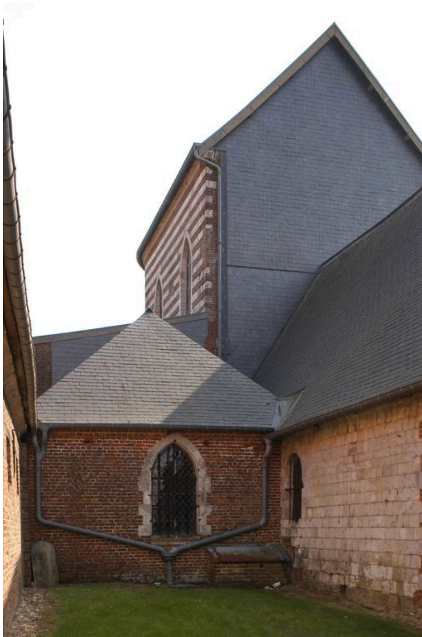
Vue du transept et du mur nord.
