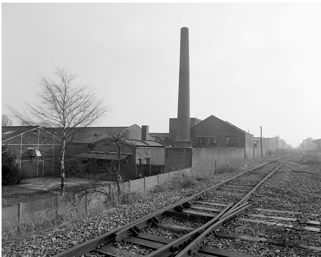
Atelier de fabrication, vue générale prise vers le sud.
