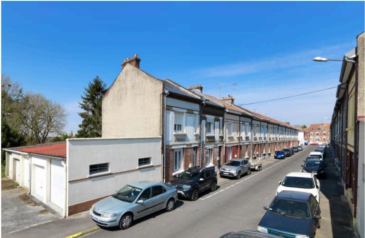
Vue de la rive ouest.
