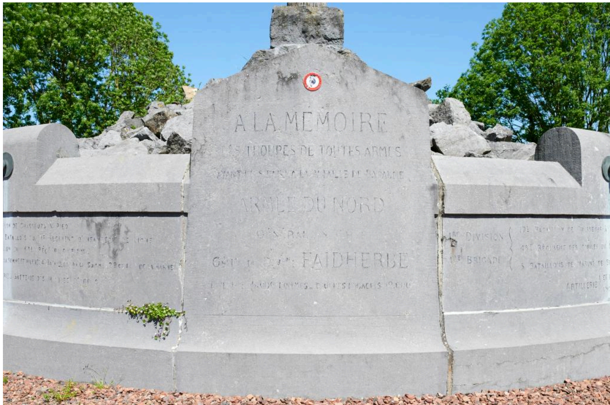
Vue de détail du panneau central avant.
