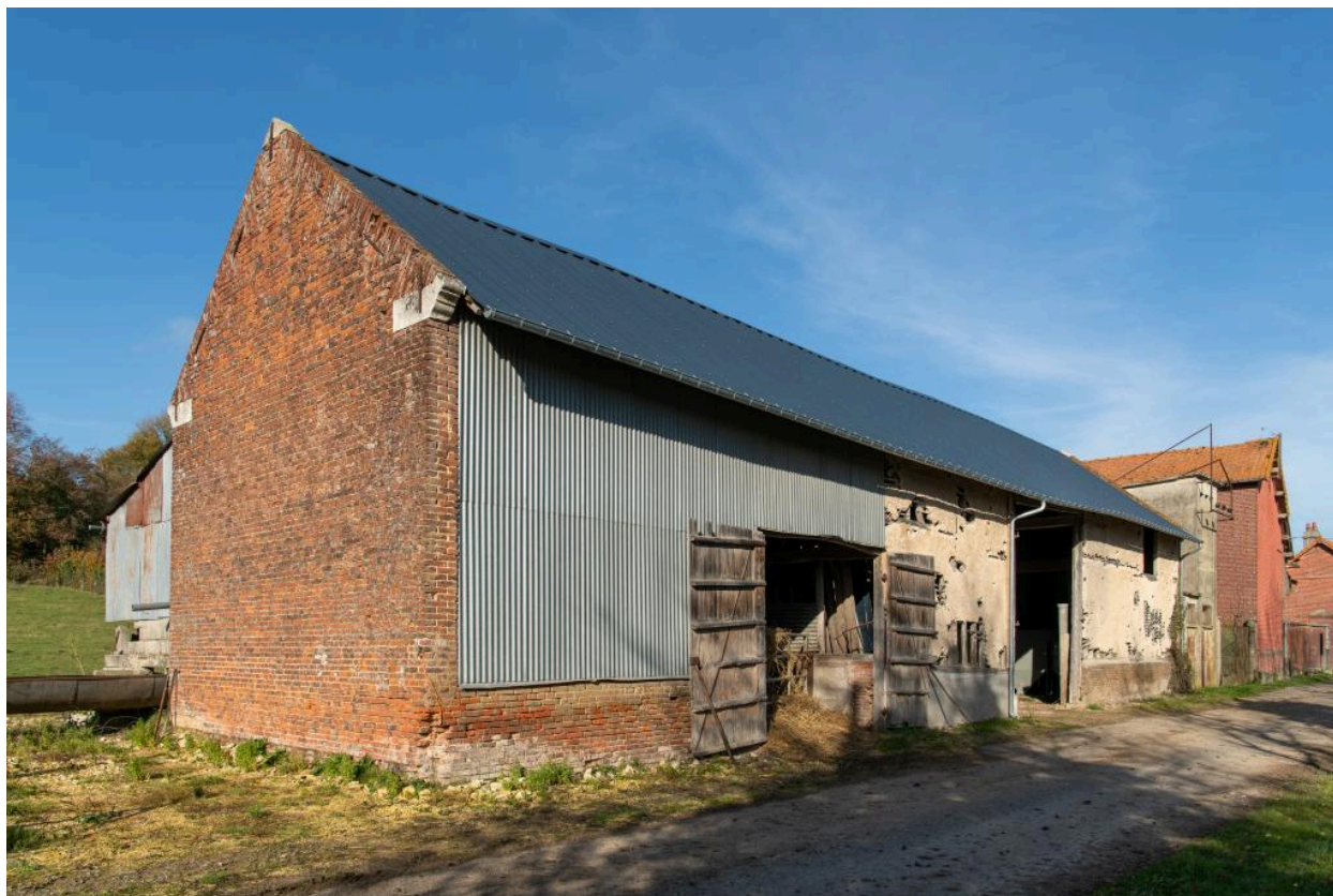
Ancienne grange et étable à côté de la laiterie (n°1 rue d'Empire), vue depuis le sud-est.
