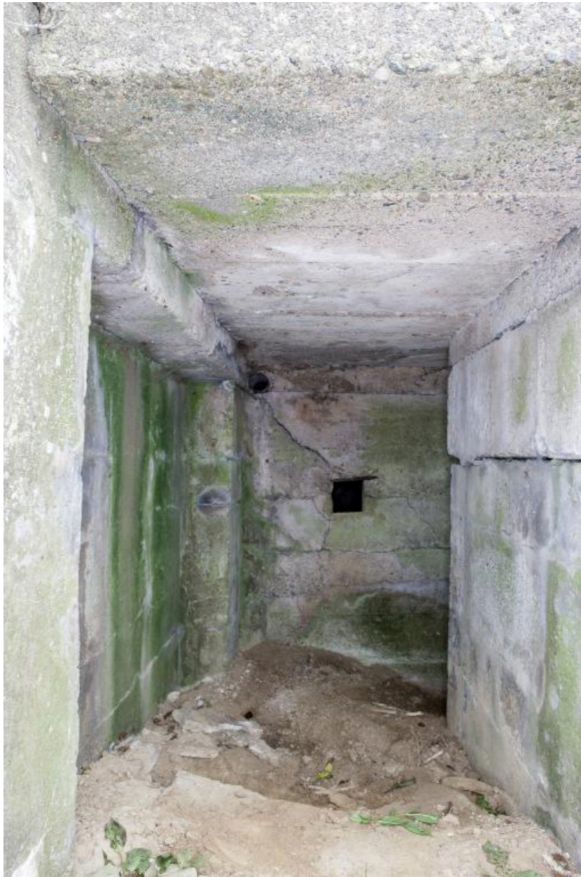
Entrée en chicane ouest. protégée par un créneau de tir.
