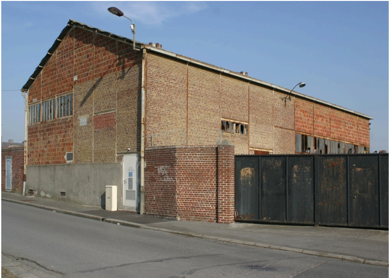
Atelier postérieur à 1919, implanté en bordure de la rue Delavenne.
