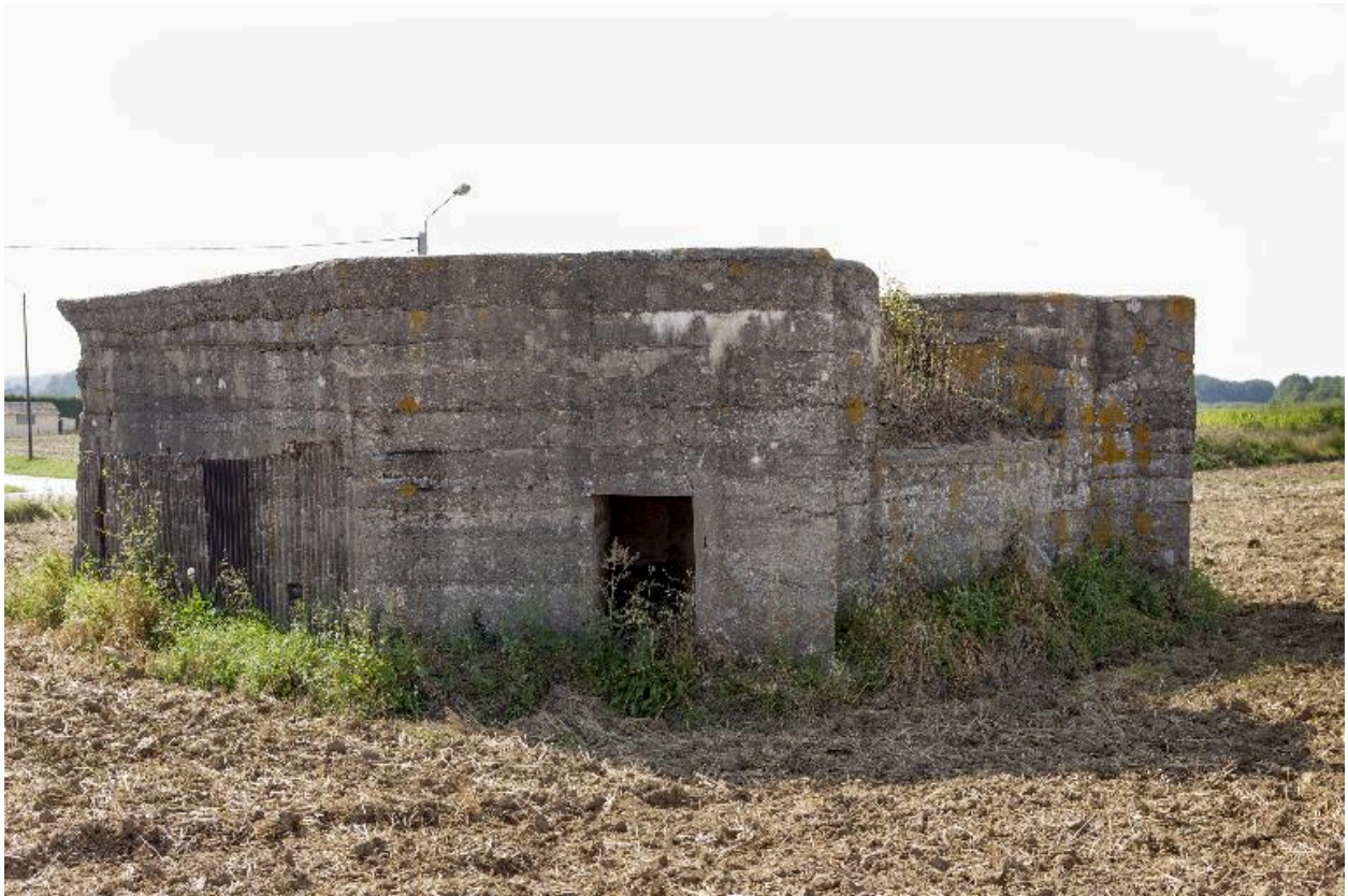
Vue de trois-quarts vers l'ouest. Entrée est
