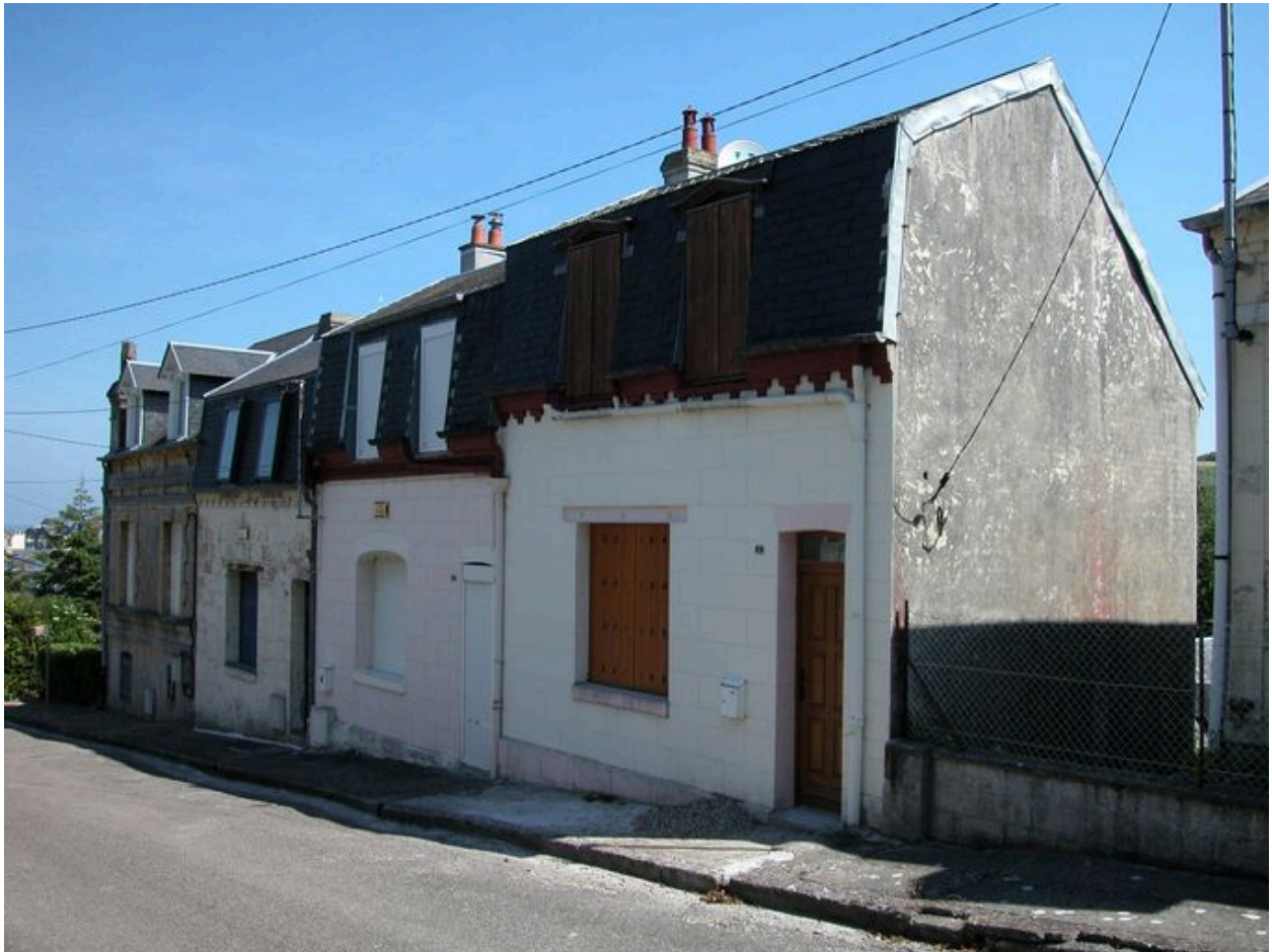
Vue d'ensemble depuis le boulevard Delarue.
