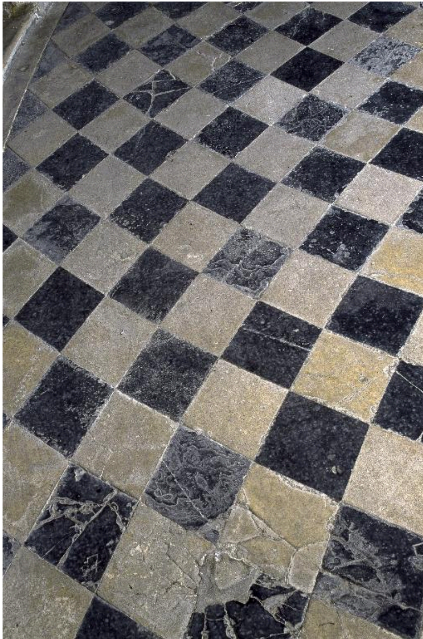
Détail du carrelage de sol du déambulatoire.
