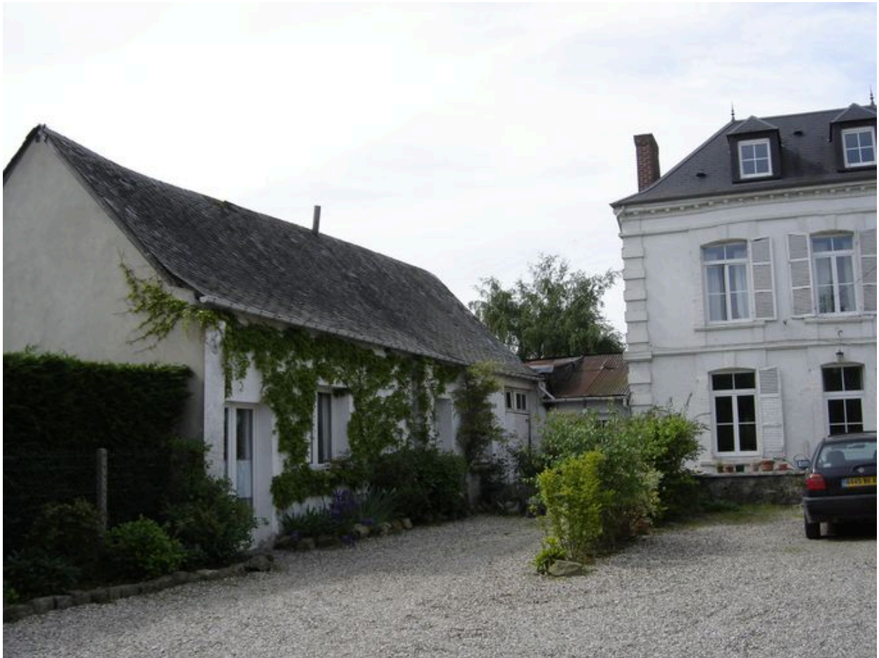
Vue des autres bâtiments agricoles faisant pendant.
