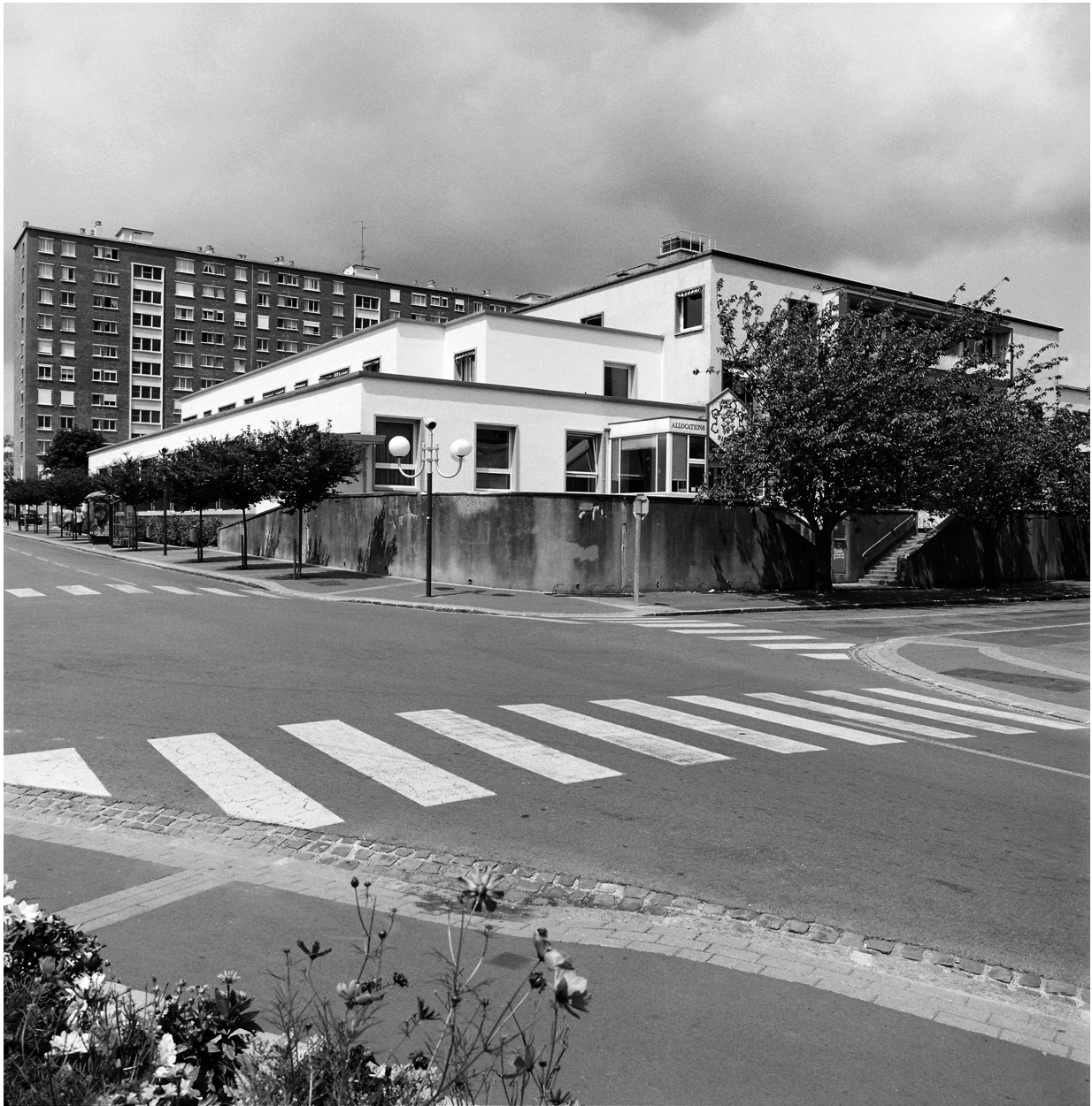
Vue générale des élévations donnant sur la place de Wattignies et l'avenue de Verdun.
