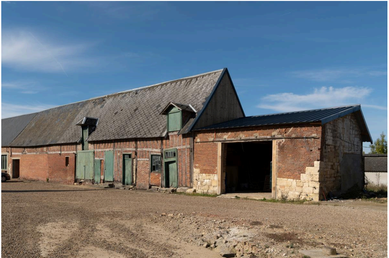
Anciens logements des ouvriers et écuries, vue depuis l'est.
