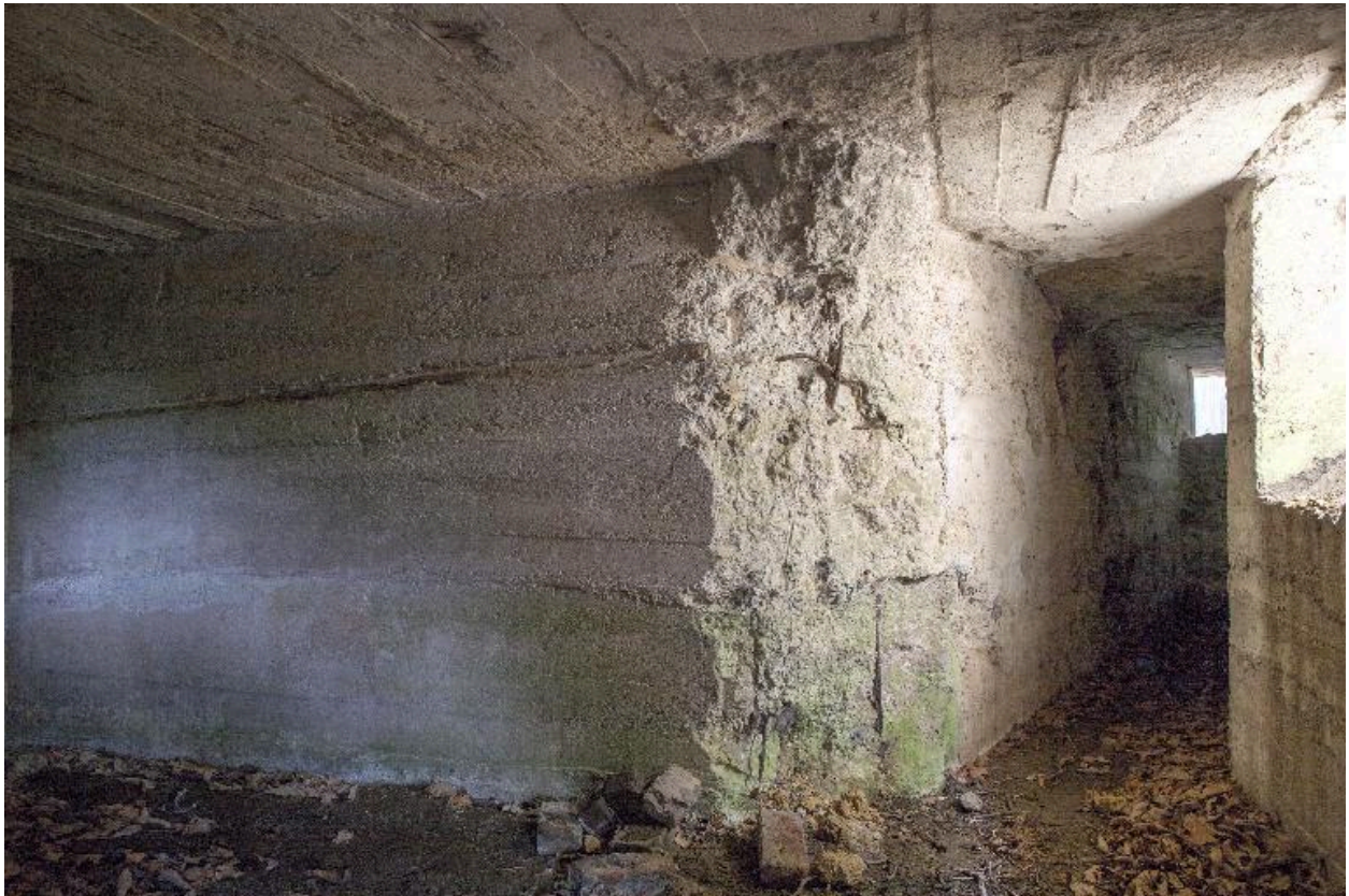
Vue intérieure vers l'est. A gauche, une des deux salles de l'édifice. A droite le couloir qui s'infléchit vers le sud.
