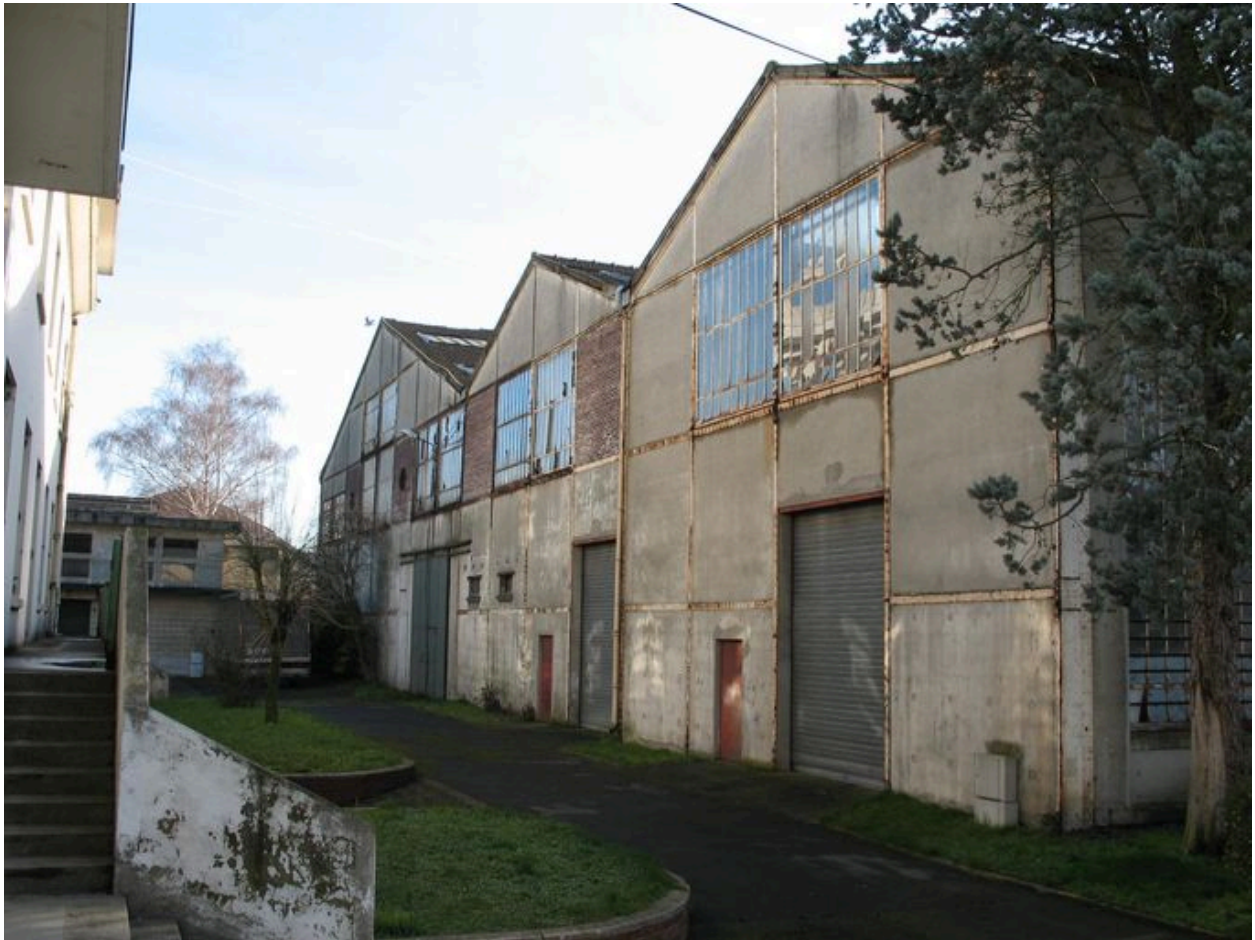
Les trois halles vue vers l'est.
