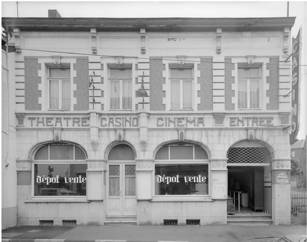
Salle des fêtes dite le Casino à Hautmont.
