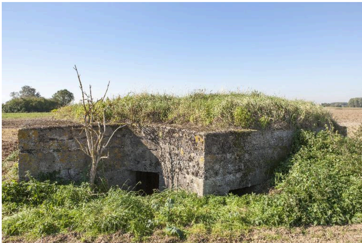
Vue vers le ouest. Entrées est et nord-est
