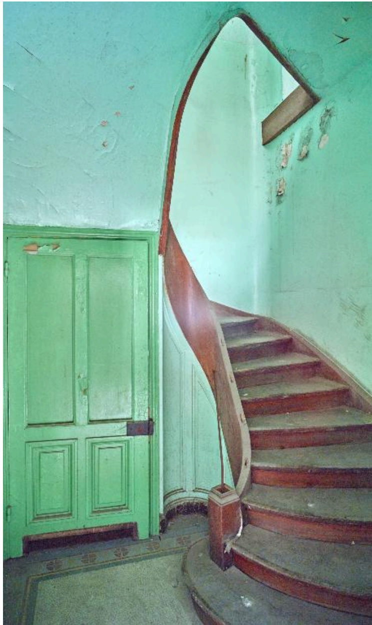
Bâtiment central. Détail de l'escalier nord du vestibule.
