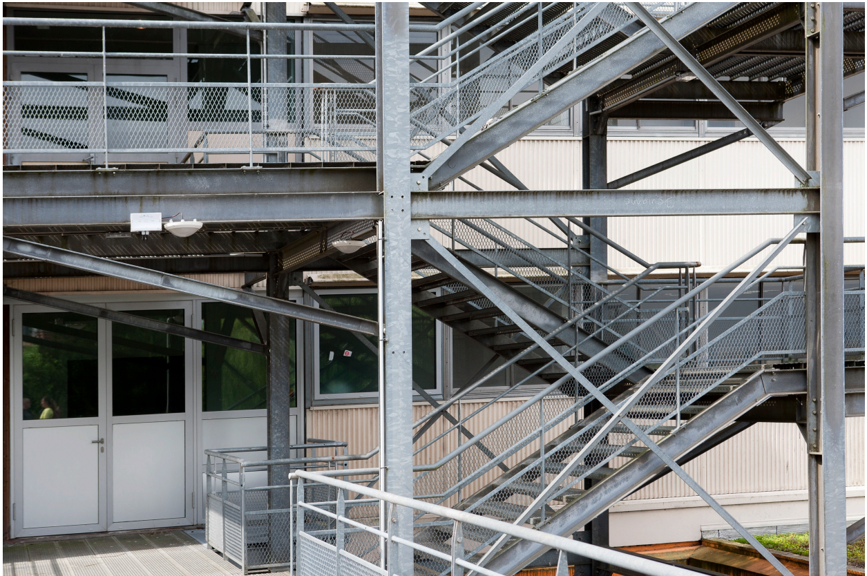
Escaliers métalliques extérieurs hors oeuvre (détail) sur la façade sud de l'externat de garçons (lycée), 2016.
