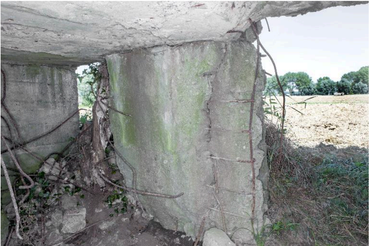
Mur nord-est, en partie exposé
