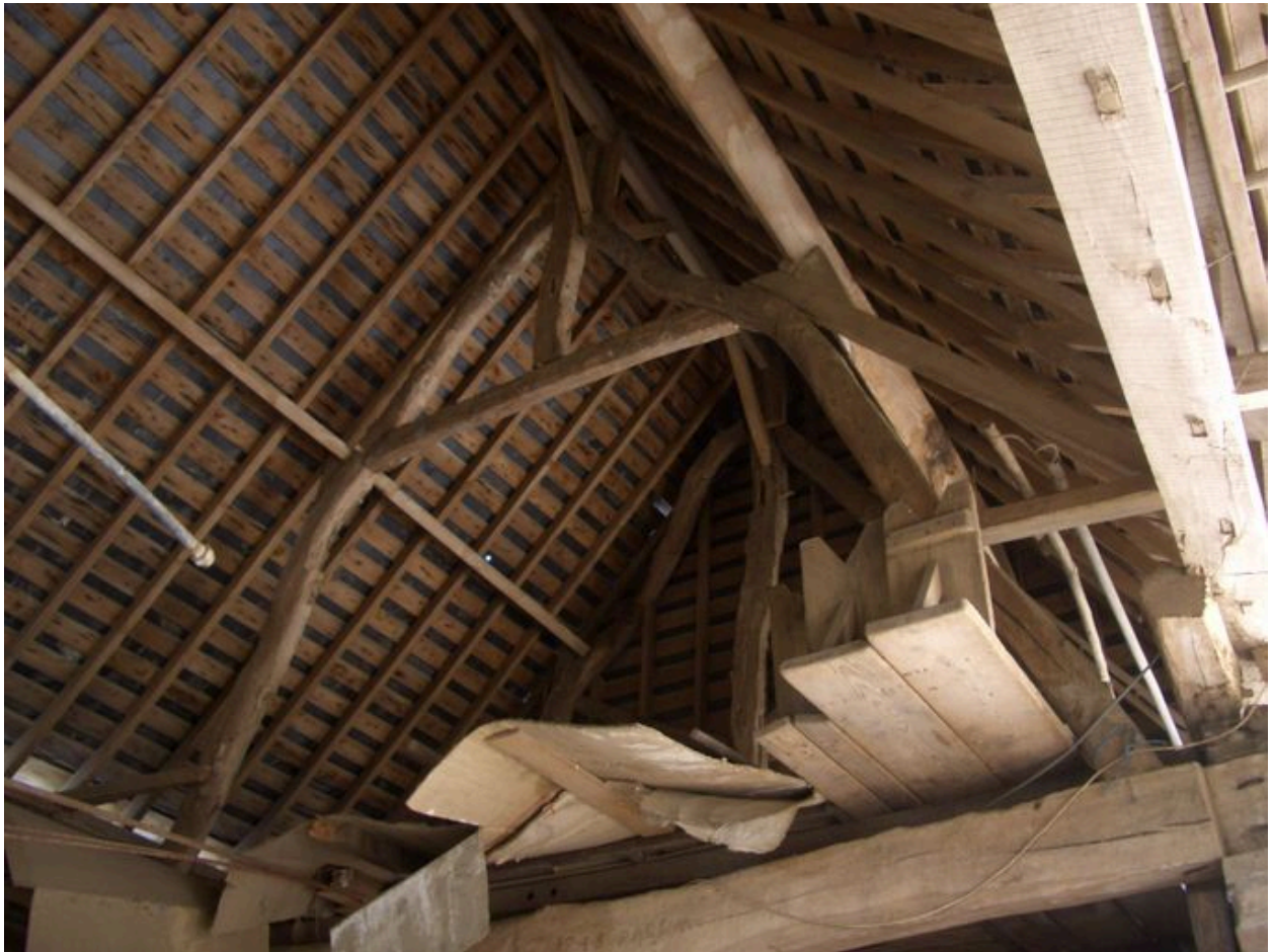
Vue détaillée d'une ferme de cette grange.
