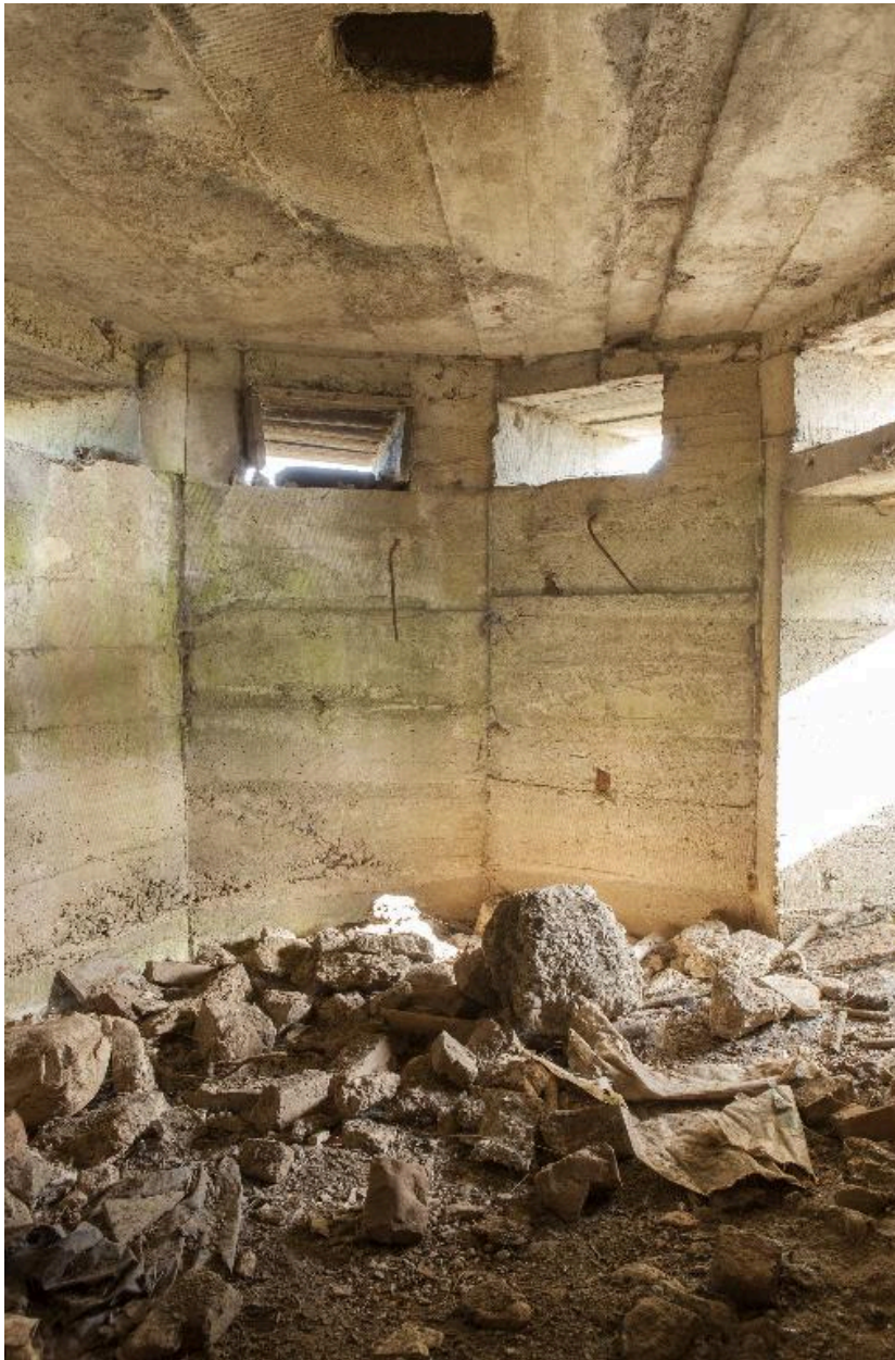
Vue intérieure, vers le nord
