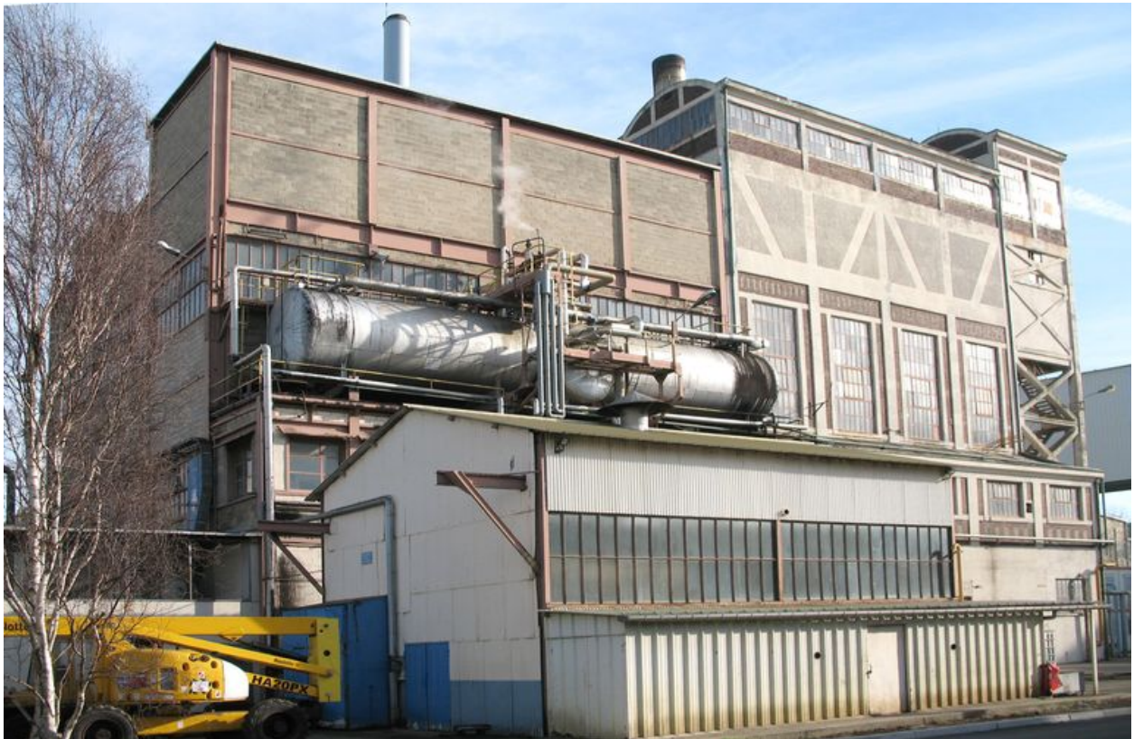
Elévation ouest de la centrale vapeur.
