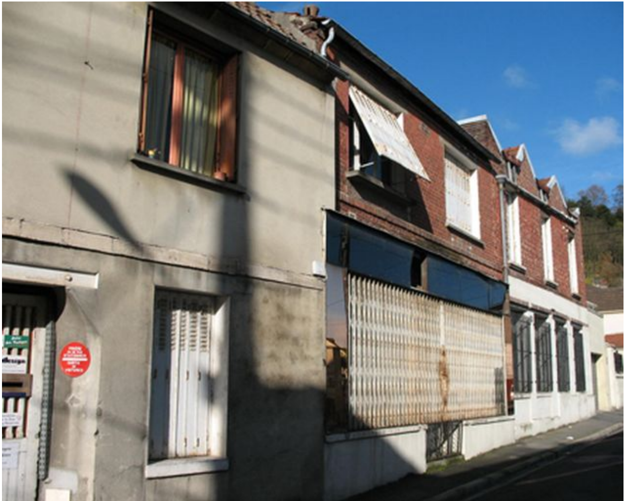
Vue générale de l'usine de confection.
