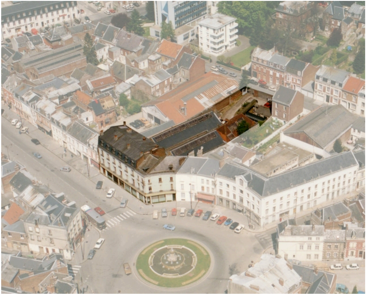
Vue aérienne, vers 1989 (BM Saint-Quentin).
