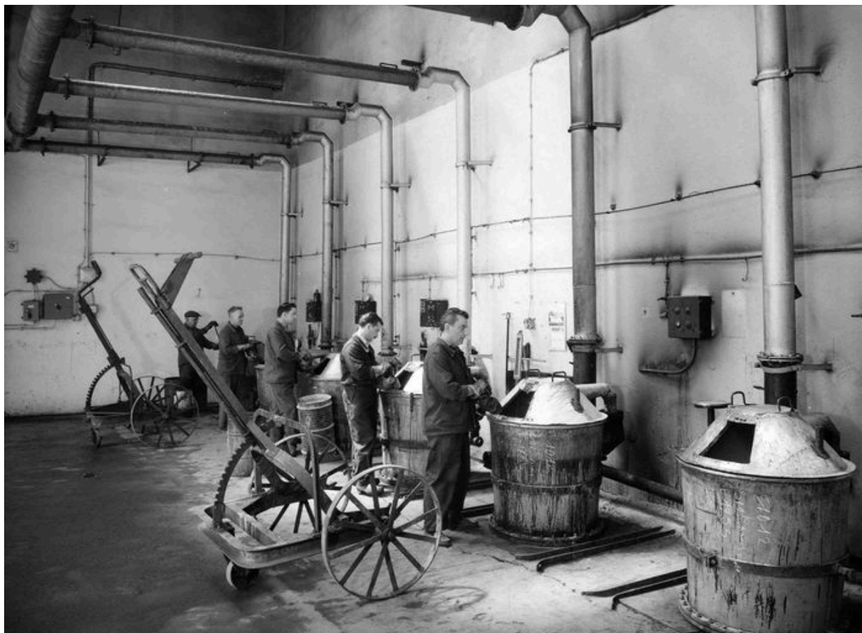
Cuisson des vernis en matras, vers 1950 (archives d'entreprise).
