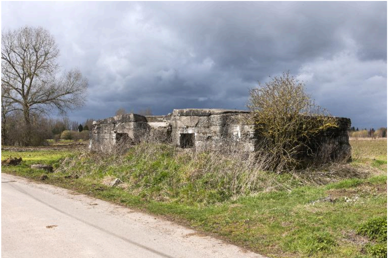
Vue générale vers l'ouest, depuis la rue du Bois Level.
