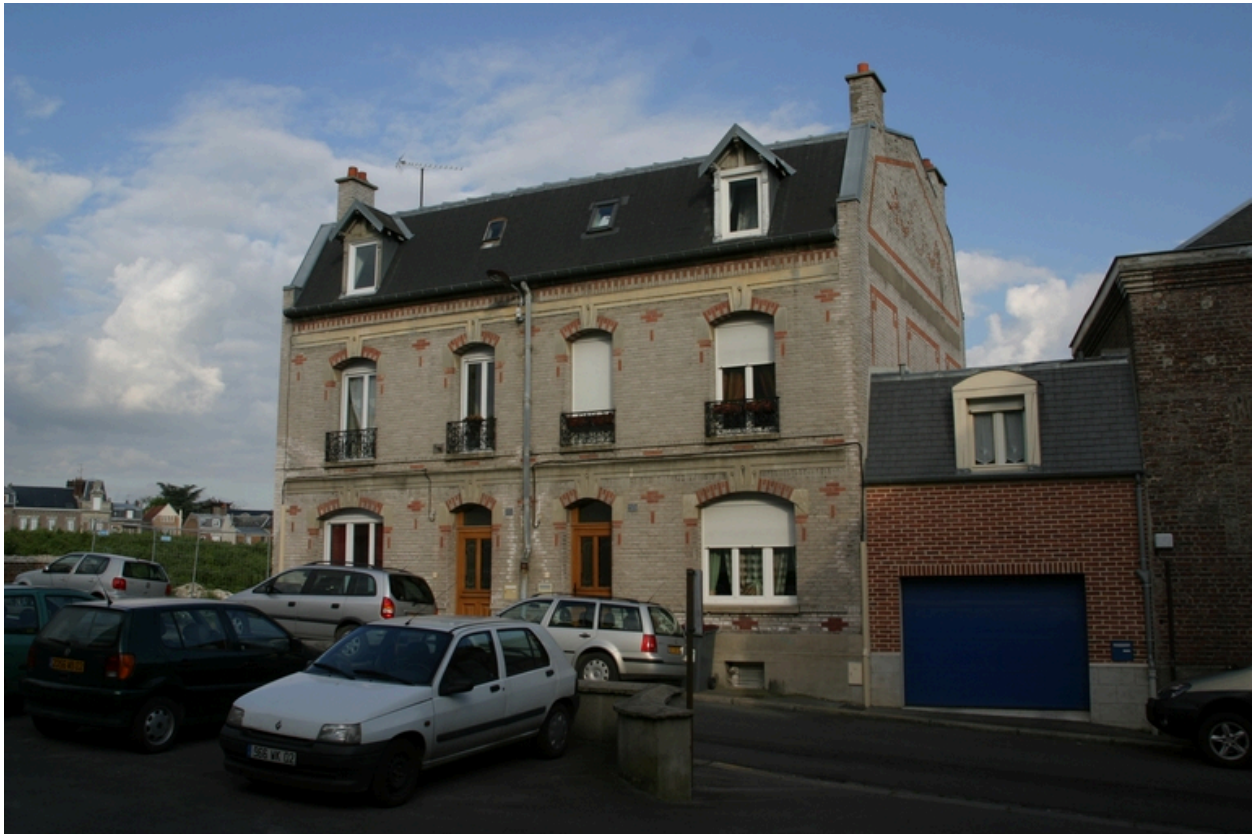
Façade antérieure des logements d'employés.
