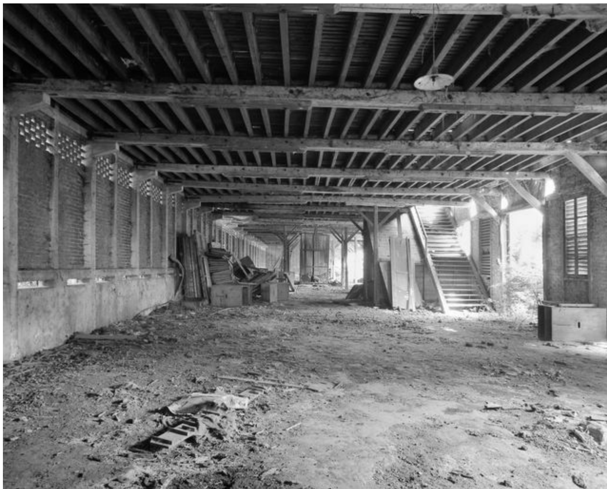
Séchoir à bois, en 1989 : vue intérieure.
