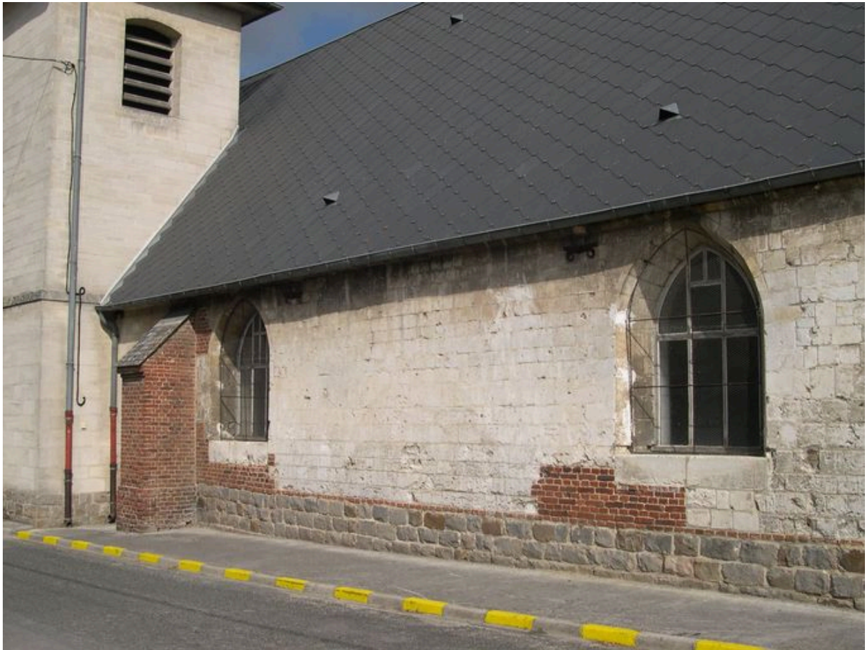
Fenêtres de la nef (mur sud).
