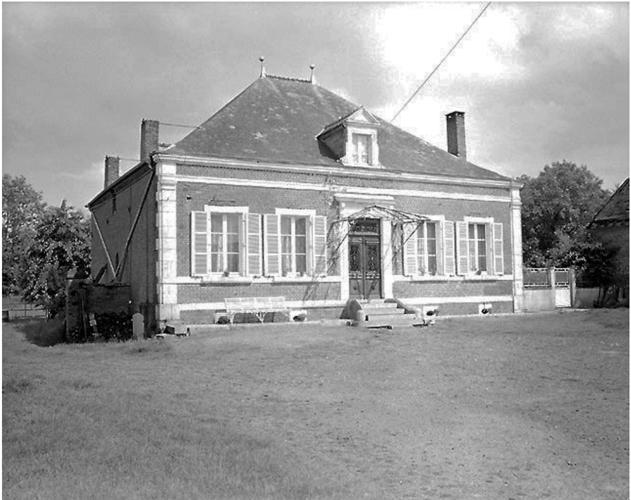
Vue principale du logis.
