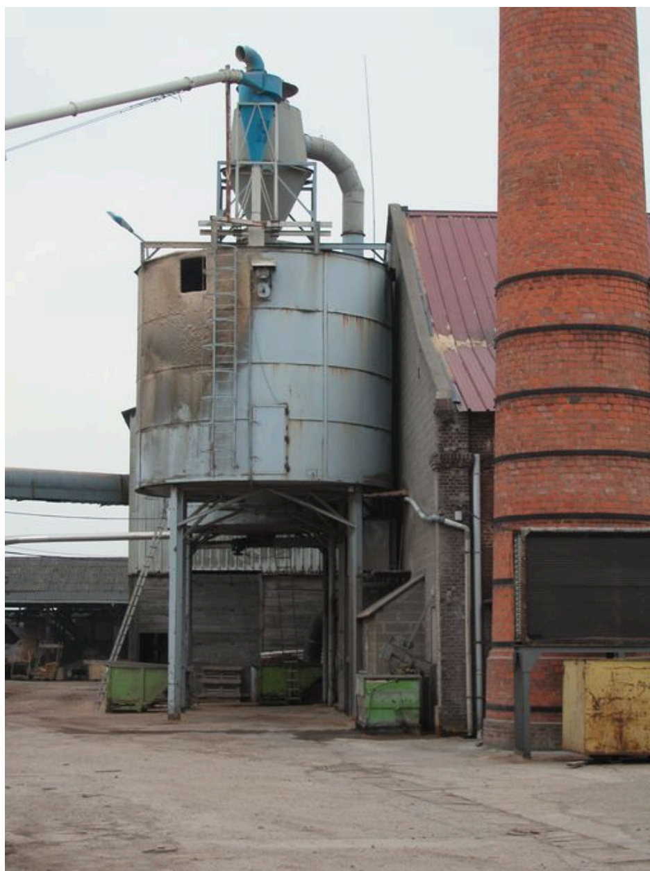
Réservoir à sciures accolée à la chaufferie et sa cheminée.
