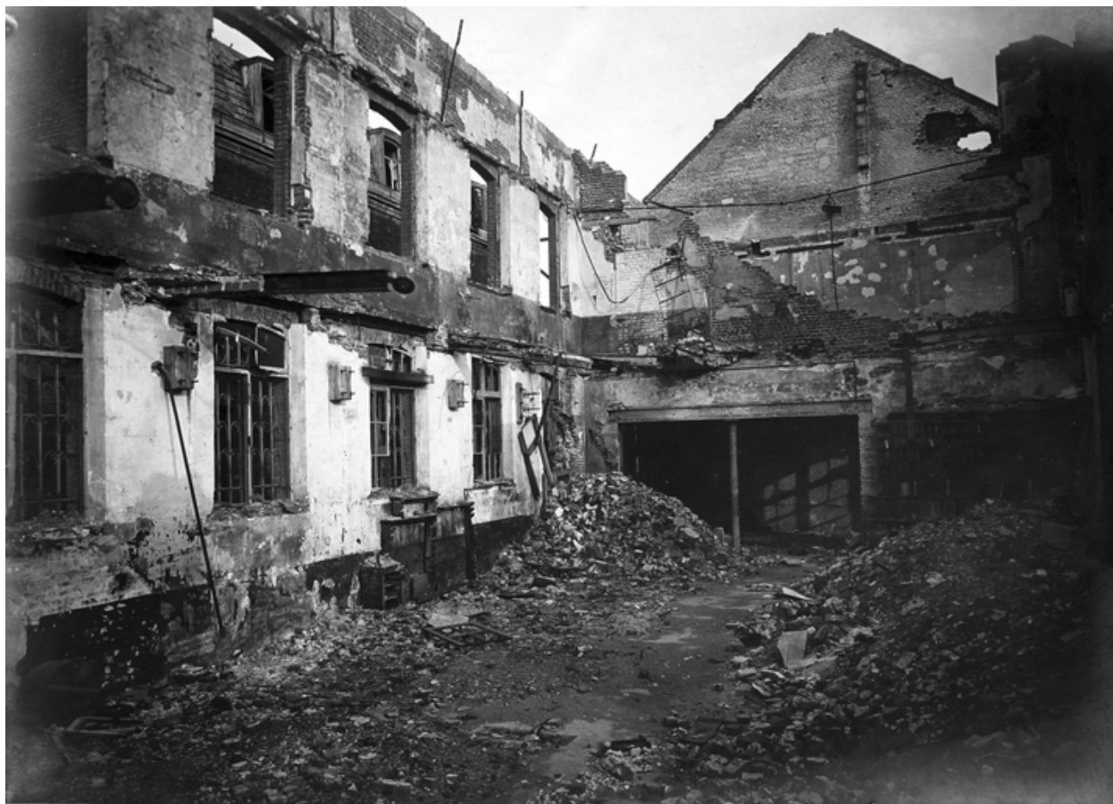
Ruines des ateliers de l'imprimerie Dupré & Thellier, place de l'Hôtel de Ville (AD Aisne).
